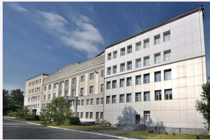
Здание ЦНБ УрО РАН (современный вид)
