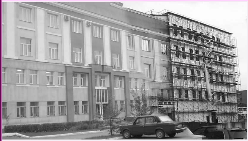
Реконструкция здания ЦНБ УрО РАН
